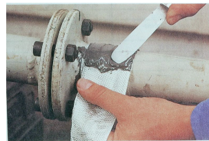
Tetting av lekkasje på rørledning
